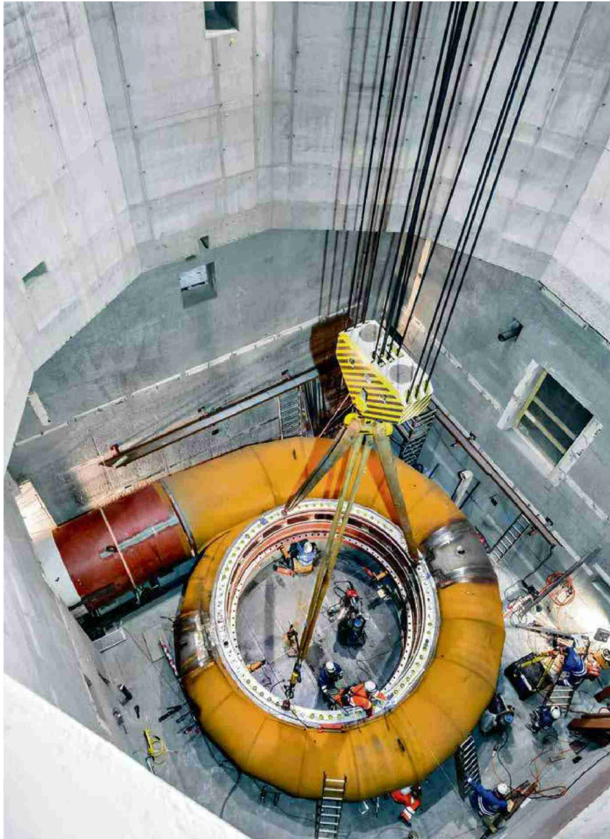
Chantier de Nant de Drance: le montage d'une bache-spirale. (SÉBASTIEN MORET)
