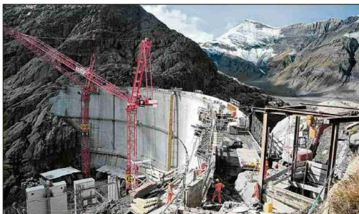
**Derniers travaux de bétonnage marquant la fin de la surélévation du barrage du Vieux-Emosson.** NANT DE DRANCE/DR
