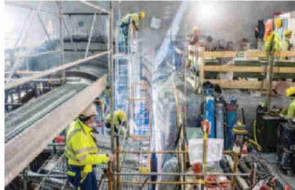
TRAVAIL Des dizaines d'ouvriers s'activent dans la salle des machines. Le chantier réunit entre 400 et 600 ouvriers en même temps.
