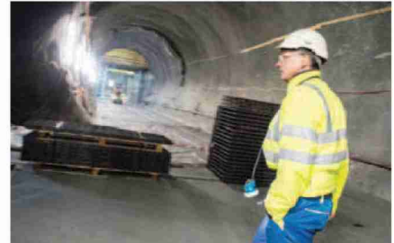
GERARD SEINGRE Responsable de la direction des travaux depuis 2008. Gérard Seingre ne se lasse pas de parcourir les galeries de Nant de Drance.
