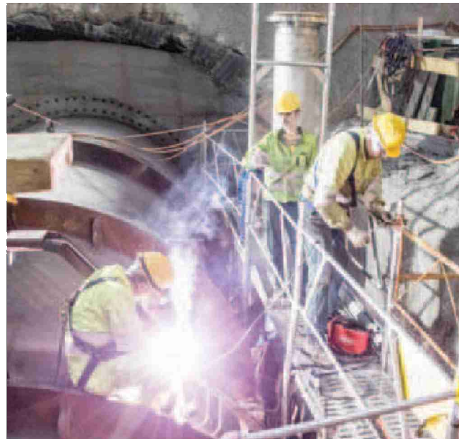
Les spécialistes s'activent autour des aspirateurs des turbines qui sont en train de prendre place dans la caverne des machines. LOUIS DASSELBORNE
