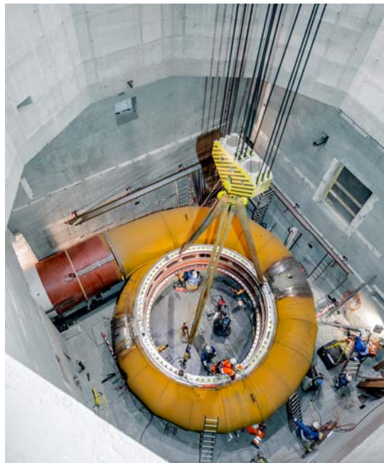
Einbau eines Spiralgehäuses in der Baugrube
