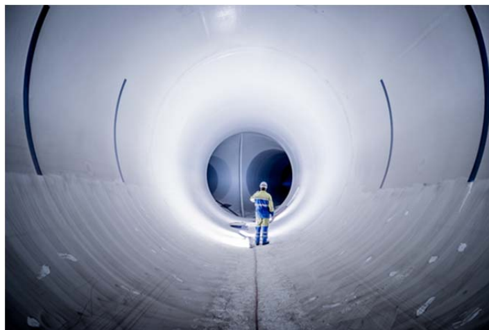
Blick vom Fuss des Vertikalschachts in Richtung Maschinengruppen
