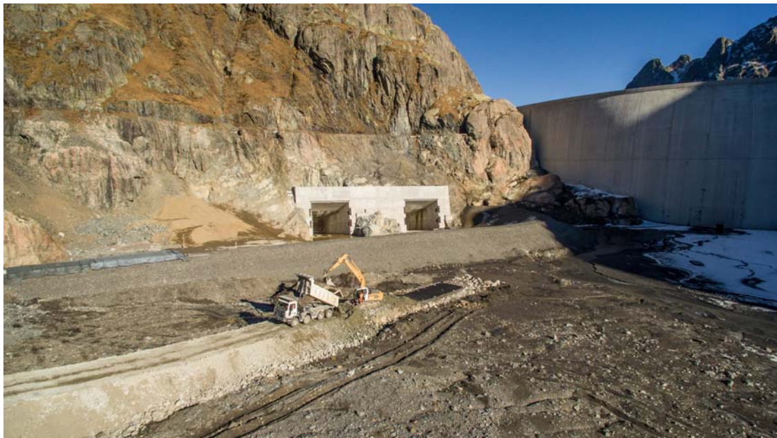
Fin du bétonnage sur les prises d'eau de Vieux-Emosson
