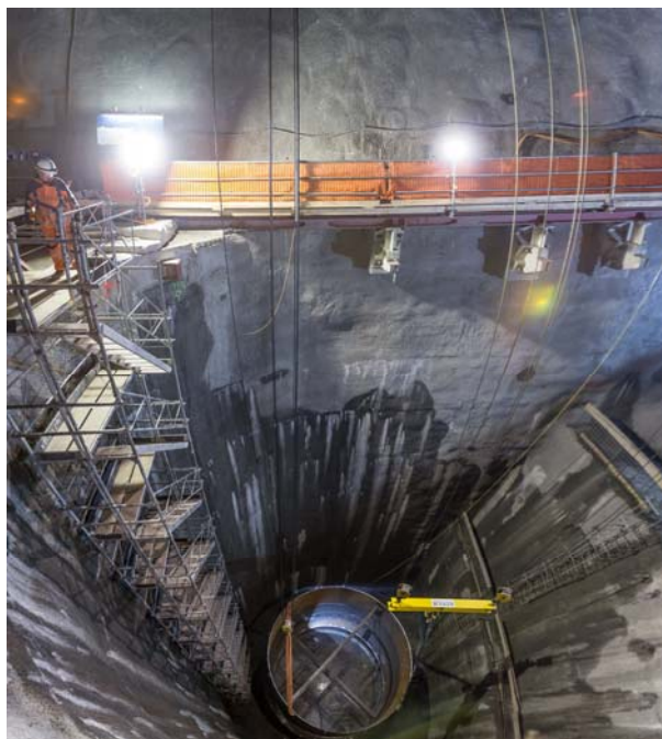
Installation d'une partie de la chaudronnerie dans un des deux puits verticaux
