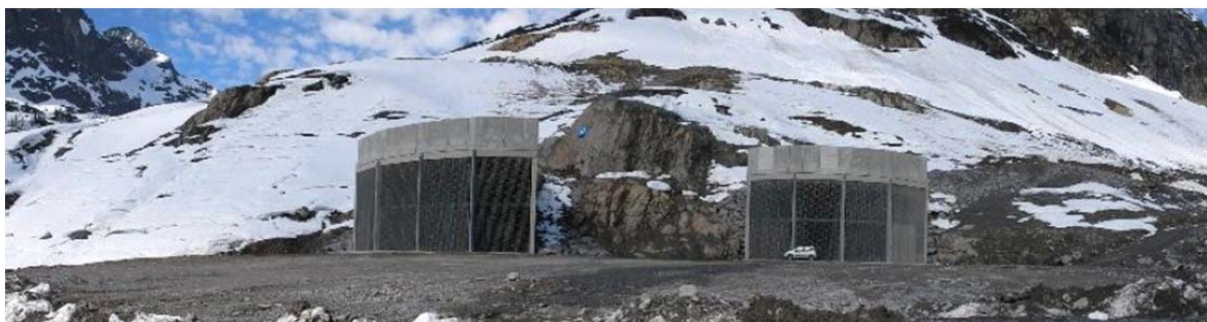
Les prises d'eau du barrage d'Emosson sont terminées.
