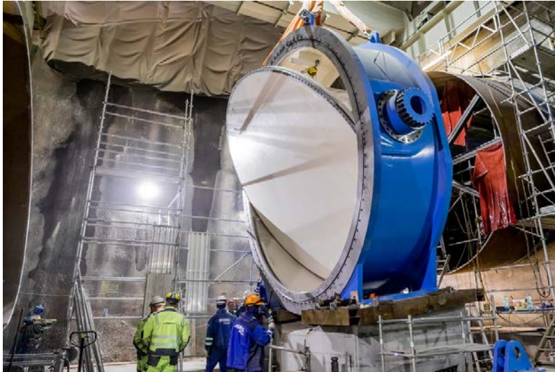
Installation d'une vanne papillon dans la conduite d'eau située au-dessus du puits vertical.
