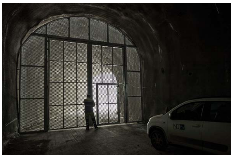
Portail d'accès aux galeries au-dessus de la caverne des machines.
