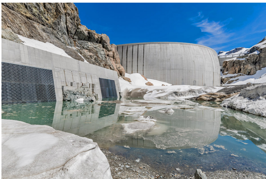
Les prises d'eau du lac de Vieux Emosson sont immergées par les eaux.
