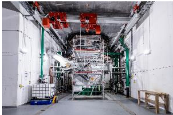
Kugelschieber während der Inbetriebsetzung
