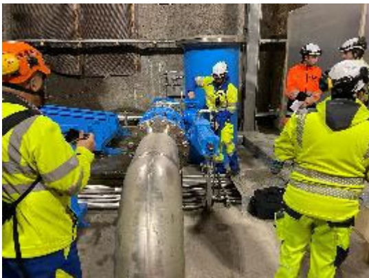
Öffnen des Ventils für die erste Befüllung des Systems
