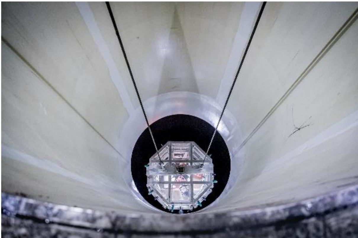
Endkontrolle der Schächte
