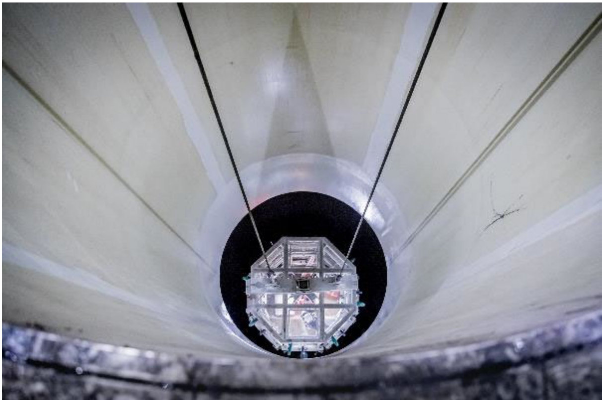
Endkontrolle der Schächte
