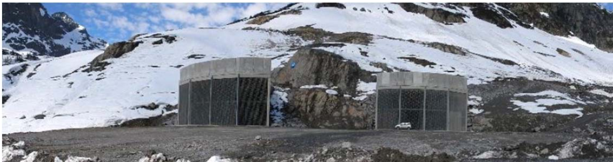
Fertiggestellte Ein-/ Auslaufbauwerke im Stausee Emosson
