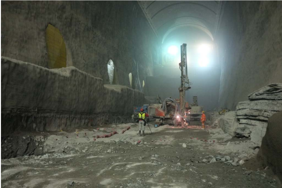
Ausgebrochene Maschinenkaverne
