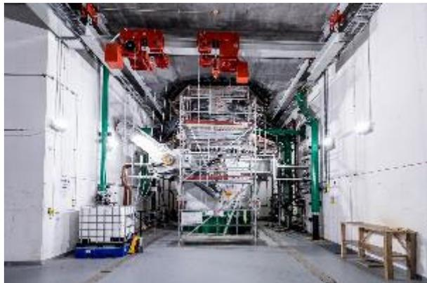
**Kugelschieber während der Inbetriebsetzung**
