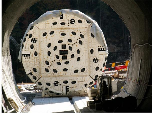
*Bohrkopf der Tunnelbohrmaschine mit Durchmesser von 9,4m am Eingang des Hauptzugangsstollen*
