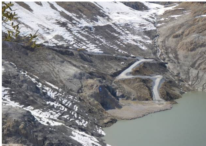
Aushub der Ein-Auslaufbauwerke und Zugangsstrasse im abgesenkten Lac d'Emosson
