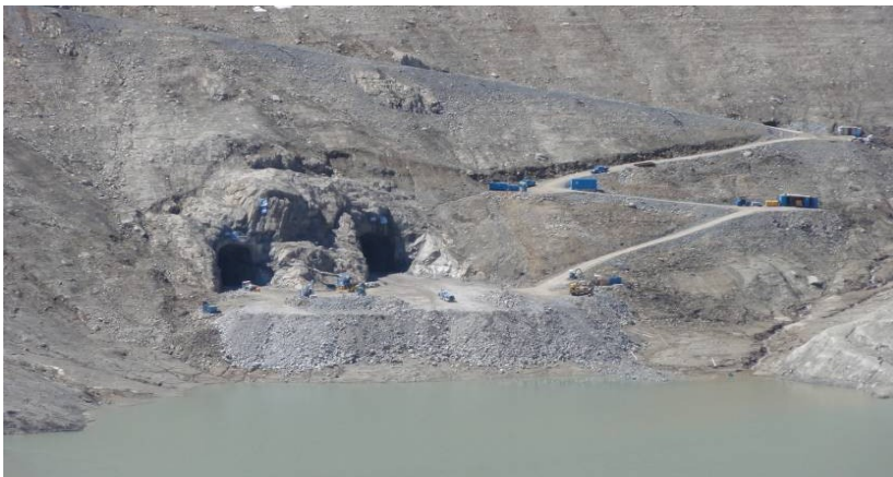
Ausbruch der beiden Triebwasserstollen im abgesenkten Lac d'Emosson
