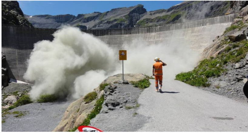
Stollendurchschlag bei Vieux Emosson
