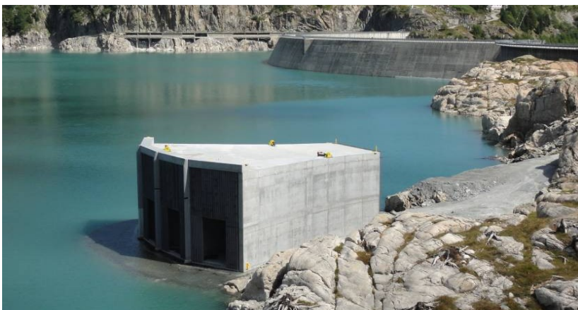
Das fertig gestellte Ein-/Auslaufbauwerk am Ufer des Lac d'Emosson
