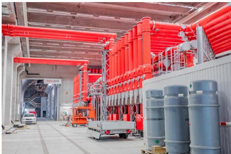
Die gasisierte 380- kV-Schaltanlage von Swissgrid in der Trafokaverne.
