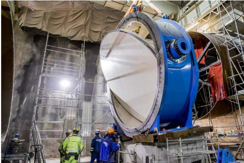
*Einbau einer Drosselklappe in den Triebwasserweg oberhalb des Vertikalschachtes.*
