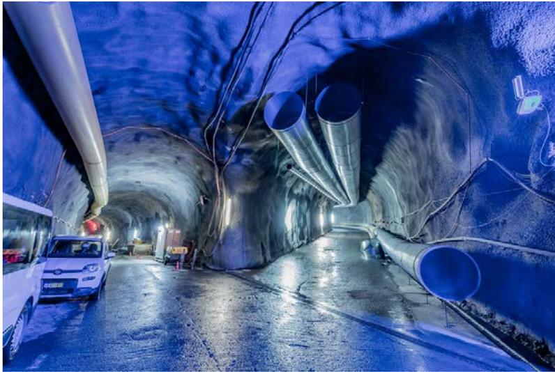
*Lüftungsrohre für den Innenausbau im Stollensystem.*
