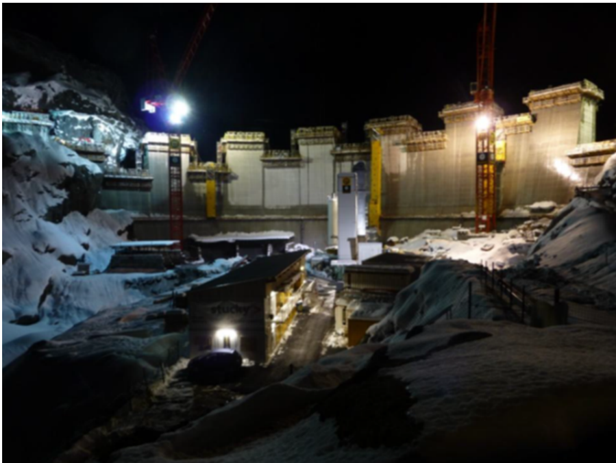
Erhöhung des Staumauer Vieux-Emosson während Winterpause
