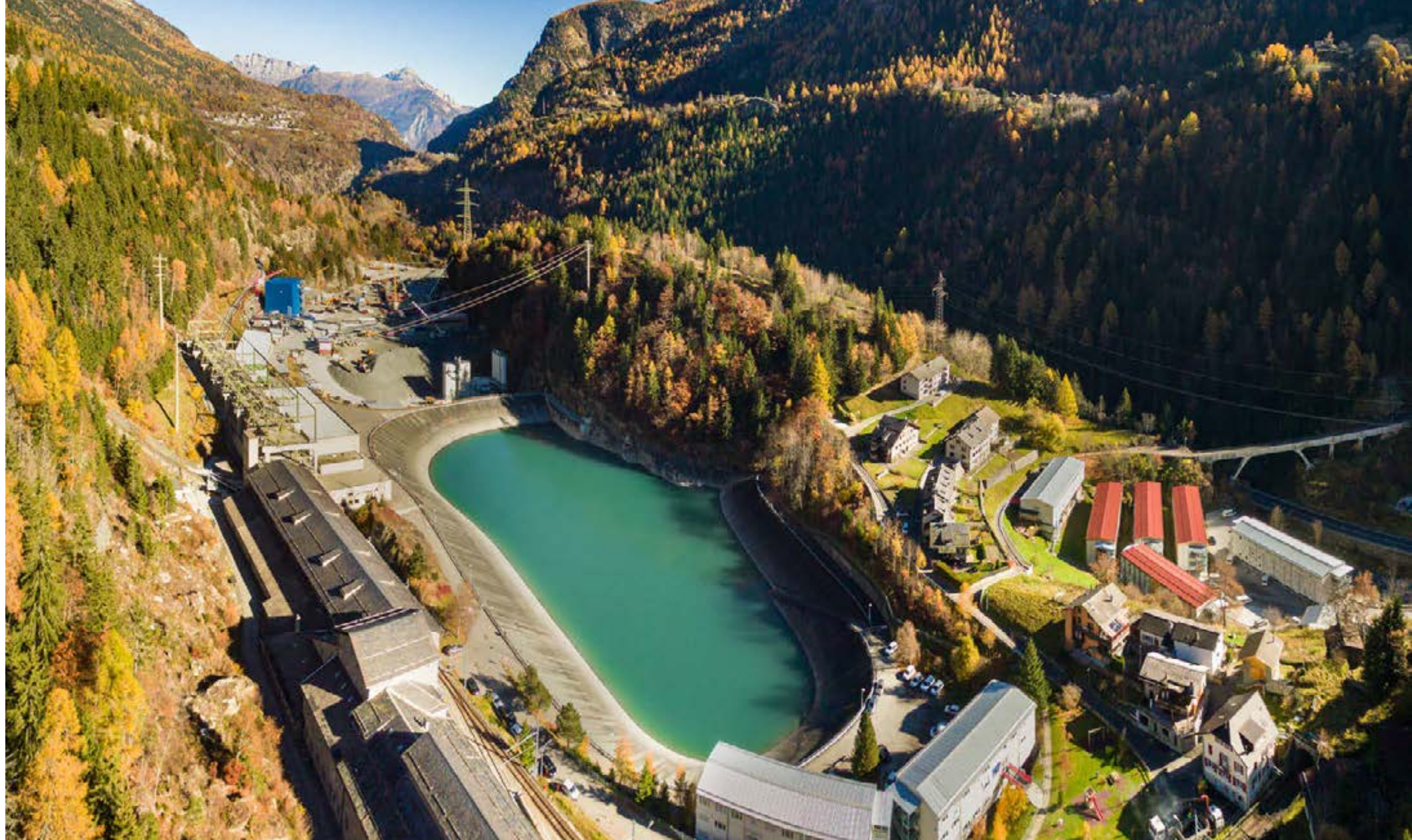
Site du Châtelard. A l'arrière plan, le portail d'entrée de Nant de Drance. En bas au centre, les bureaux de la direction des travaux. En bas sur la droite, les logements des ouvriers.
