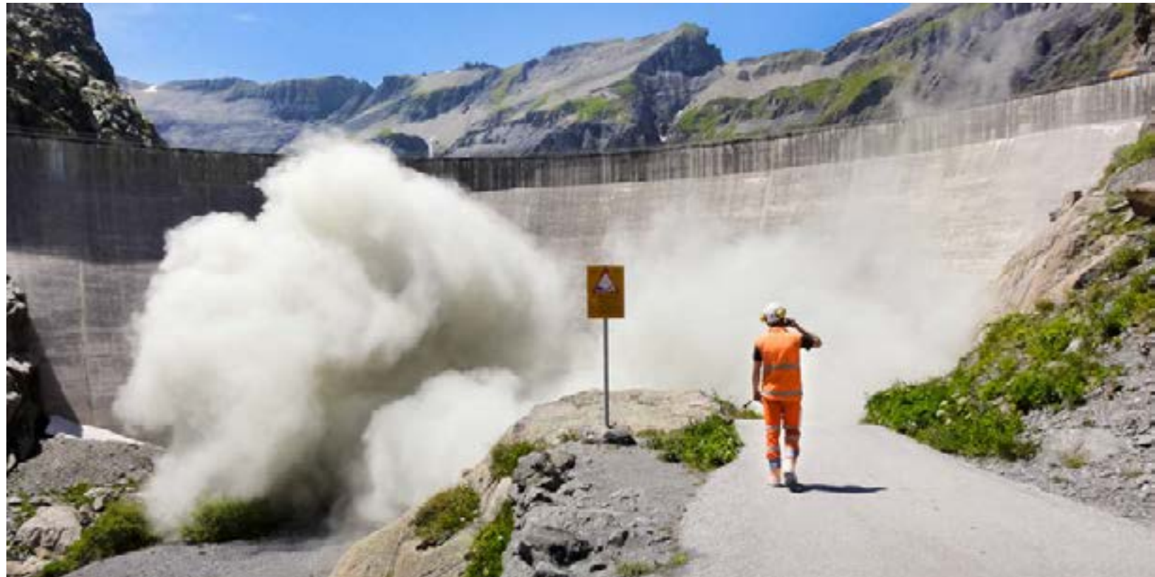
Dernier minage de la galerie d'accès.
