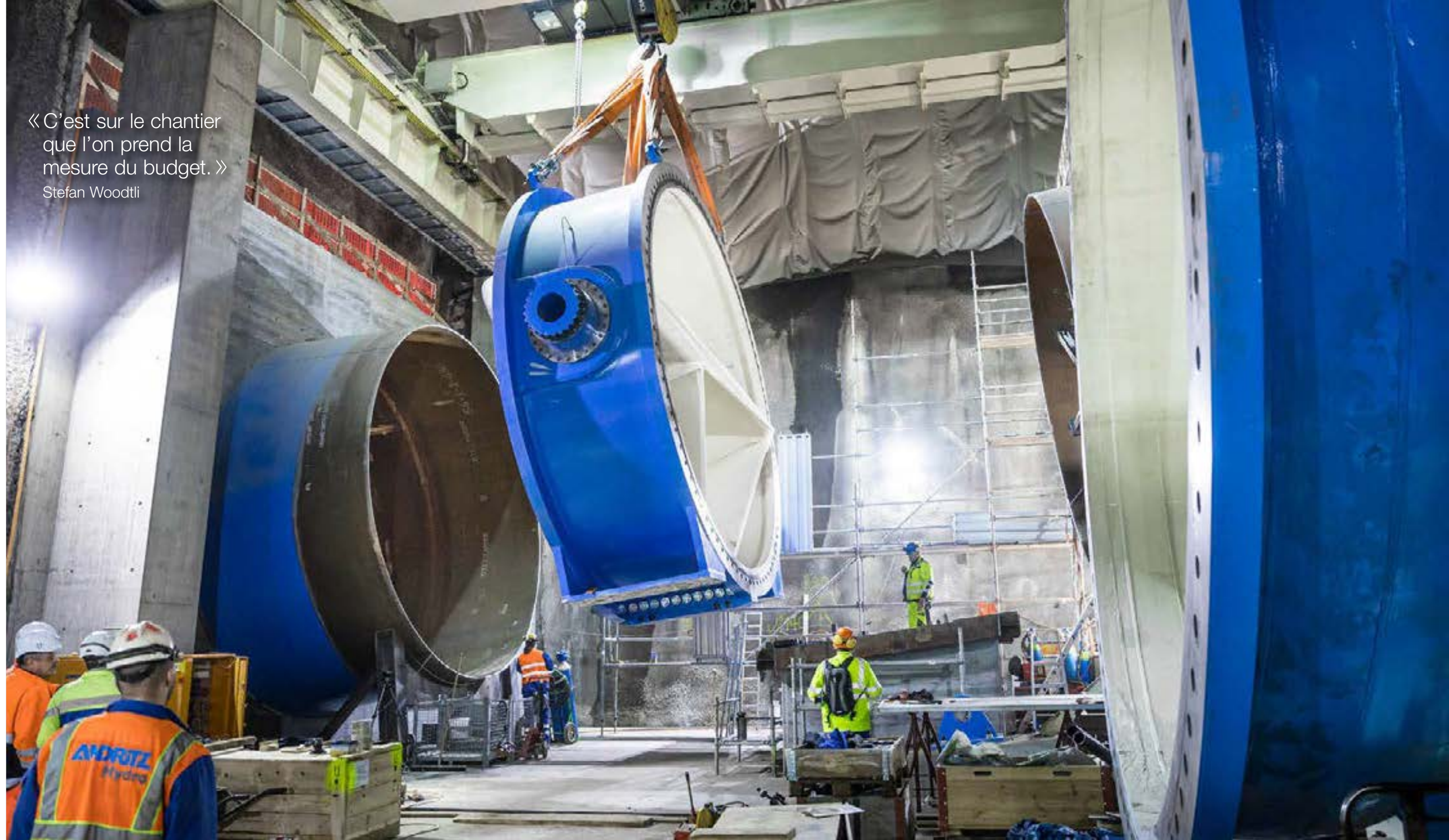
Travaux de pose d'une vanne de tête.
