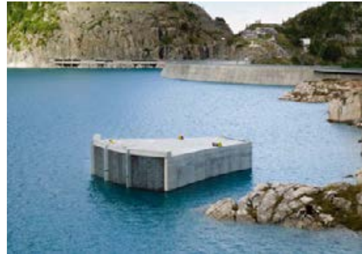
Les prises d'eau, installées au fond du lac d'Emosson.
