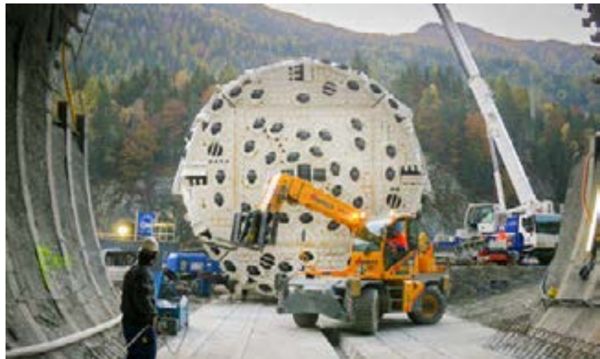
27 octobre 2009. Le tunnelier : 142 m de long, 1450 tonnes. Sa tête de forage de 200 tonnes est équipée de 61 « roues de coupe » servant à broyer la roche.
