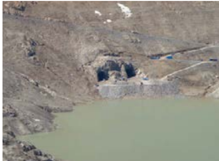
Percement des voies d'eau dans le lac d'Emosson et préparation de l'emplacement définitif des prises d'eau. Le lac a été abaissé pour ce faire.
