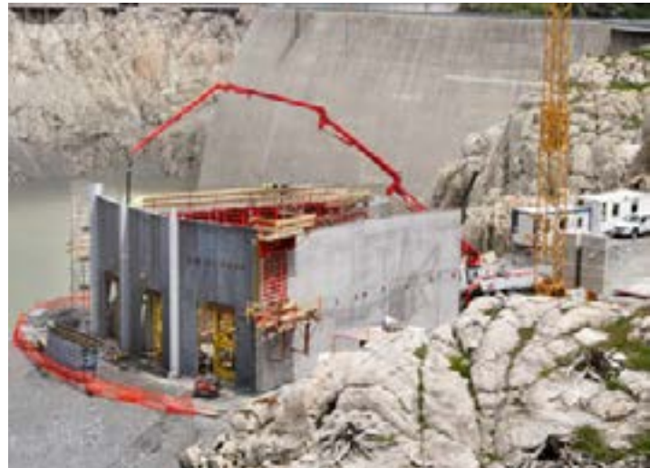
De gauche à droite: construction des prises d'eau sur une plateforme de remblai à proximité du barrage d'Emosson, progressivement immergées par la montée des eaux.
