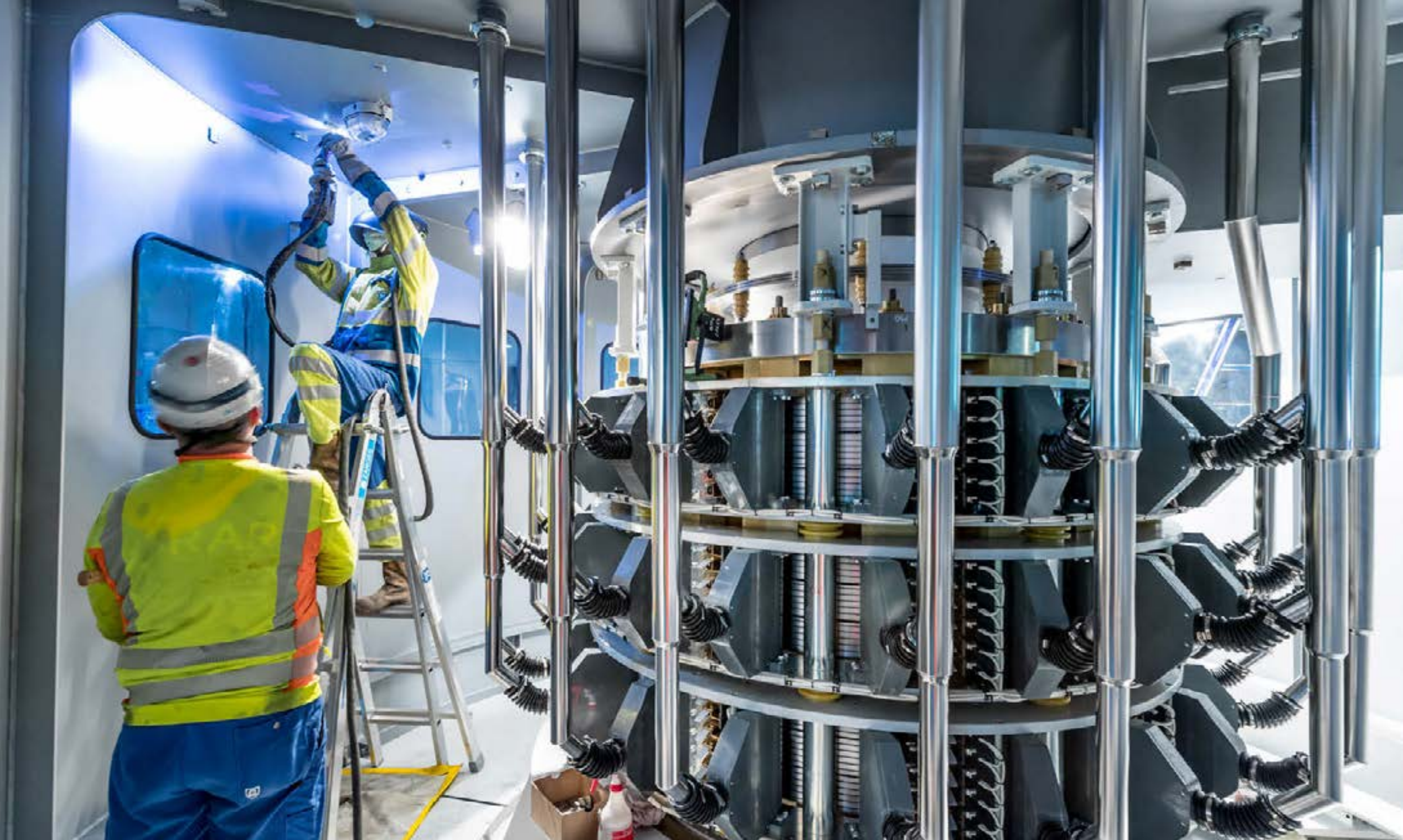
Travaux de soudure à côté de «l'excitatrice», au sommet de l'une des six machines.
