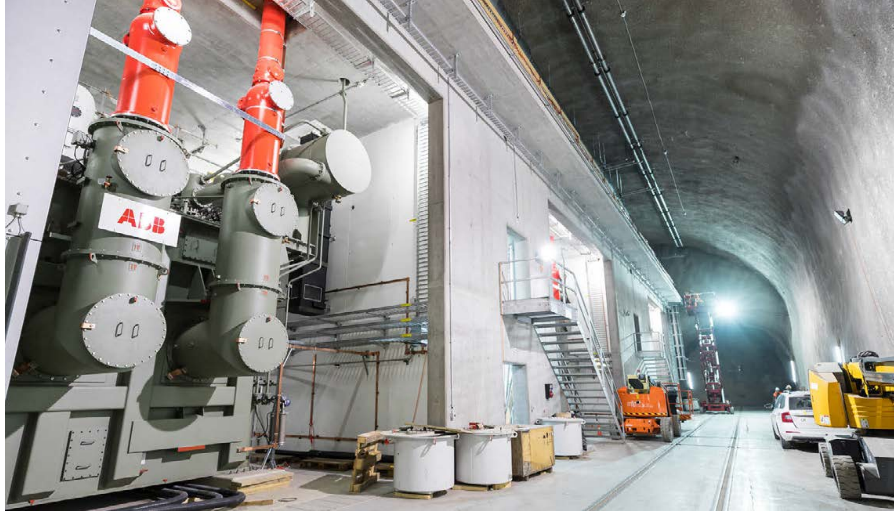
La caverne des transformateurs, longue de 130 m pour une largeur de 19 m et une hauteur de 15 m.
