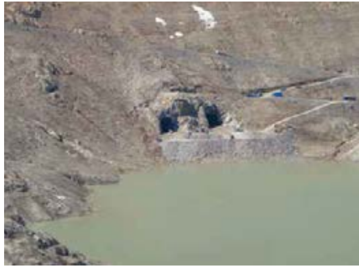
Durchbruch der Triebwasserwege im Stausee Emsosson und Vorbereitungen für die endgültige Lage der Ein- und Auslaufbauwerke. Der Stausee wurde hierfür abgesenkt.
