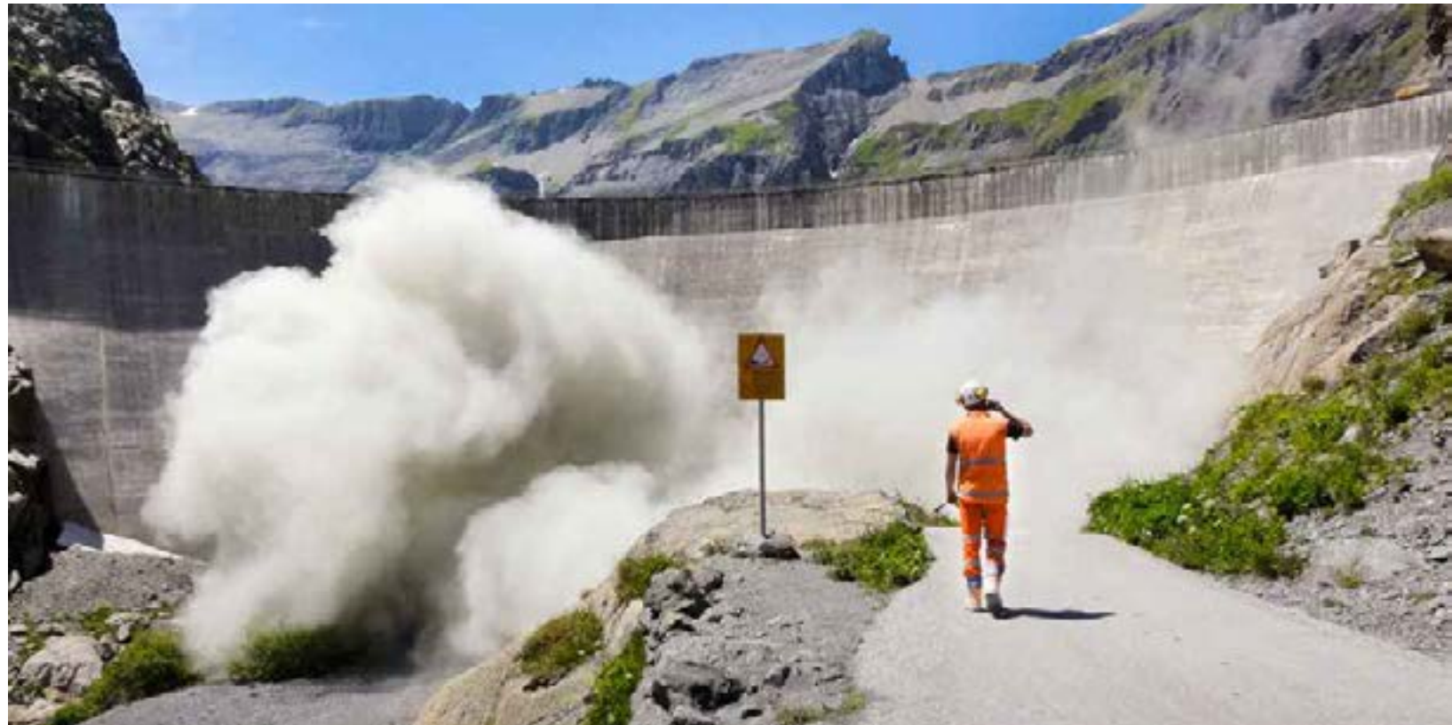
Letzte Sprengung für den Zugangstollen.
