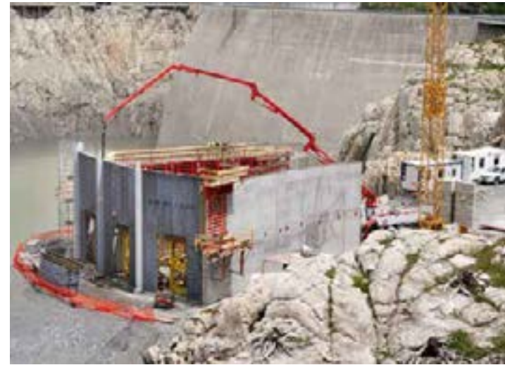
Von links nach rechts: Bau einer Wasserfassung auf einer Plattform in der Nähe der Staumauer Emsosson. Bald erreicht der ansteigende Wasserspiegel die Konstruktion.
