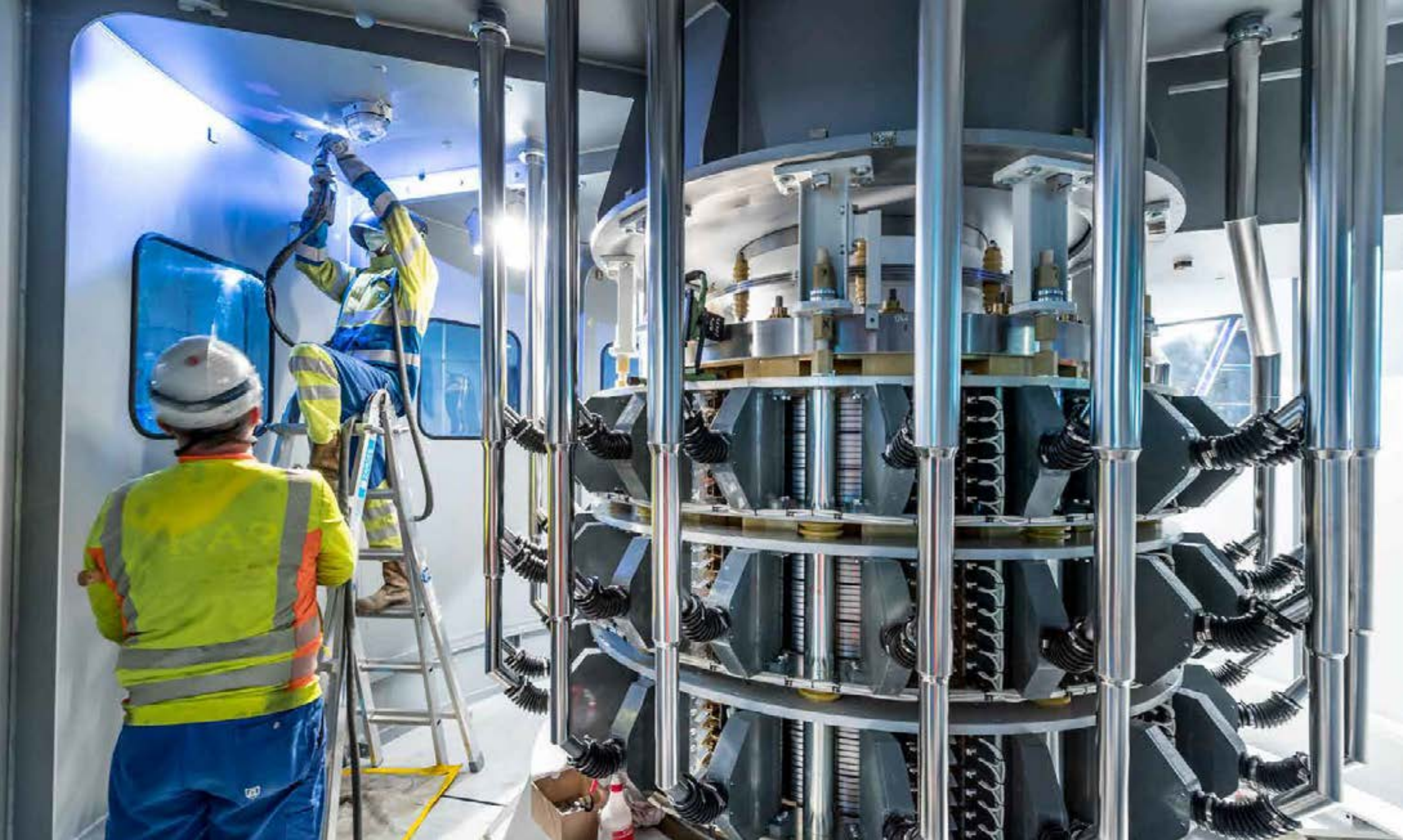
Schweissarbeiten bei der Erregermaschine am obersten Bauteil einer der sechs Maschinengruppen.
