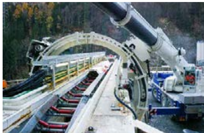
27. Oktober 2009. Die 142 m lange Tunnelbohrmaschine wiegt 1450 t. Der 200 t schwere Bohrkopf ist mit 61 Schneidrollen ausgerüstet, um das Gestein zu zerkleinern.
