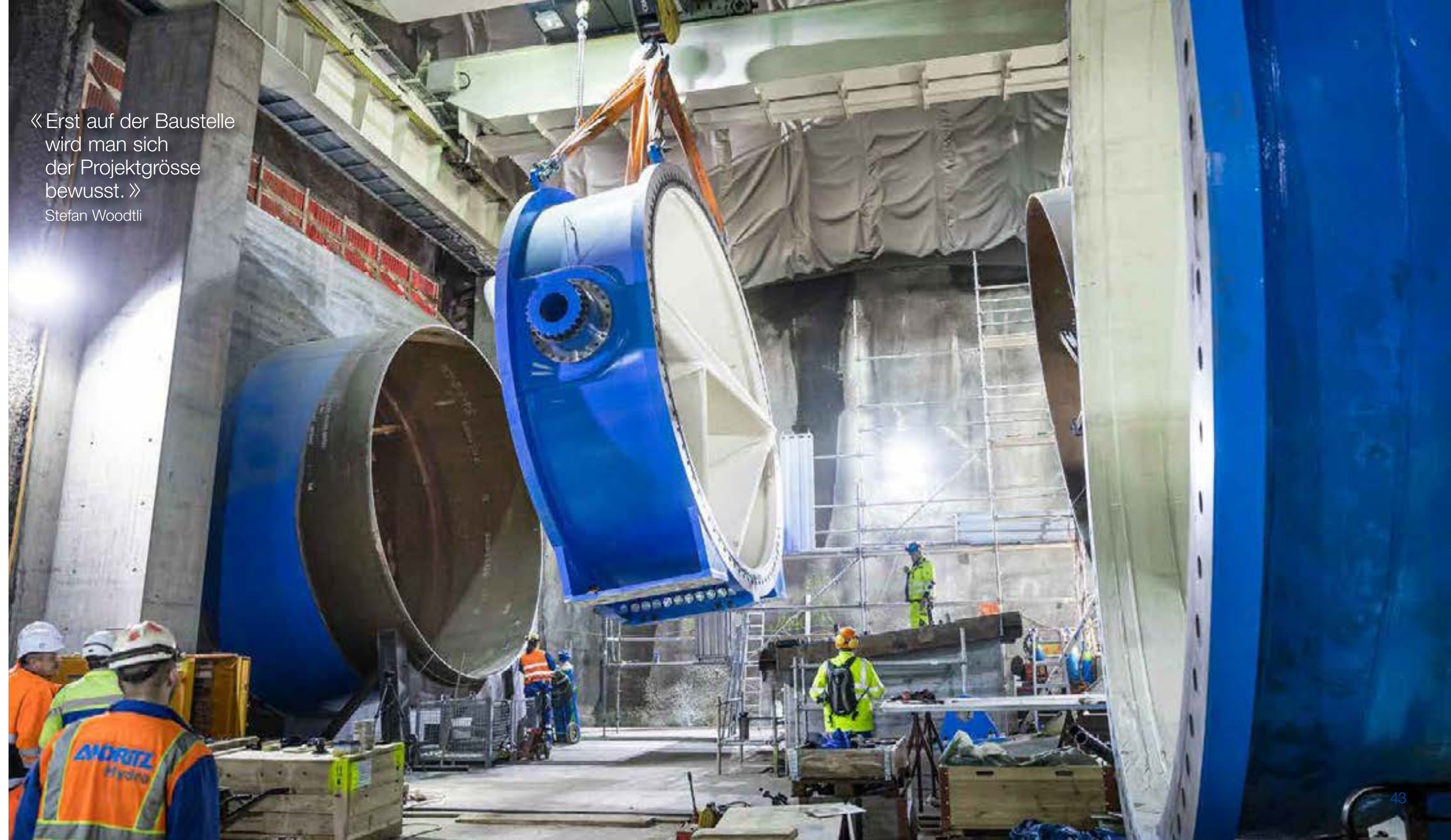
Einbauarbeiten an einer Drosselklappe.
