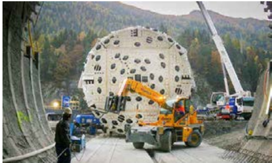
27. Oktober 2009. Die 142 m lange Tunnelbohrmaschine wiegt 1450 t. Der 200 t schwere Bohrkopf ist mit 61 Schneidrollen ausgerüstet, um das Gestein zu zerkleinern.
